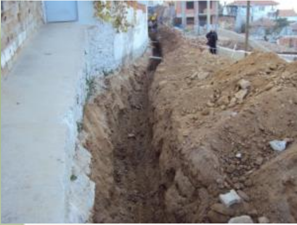
Beşeylül Mahallesi Sümer Oral Caddesi içme suyu şebekesi ana boru ve abone bağlantıları yenileme çalışmalarından görünüm
