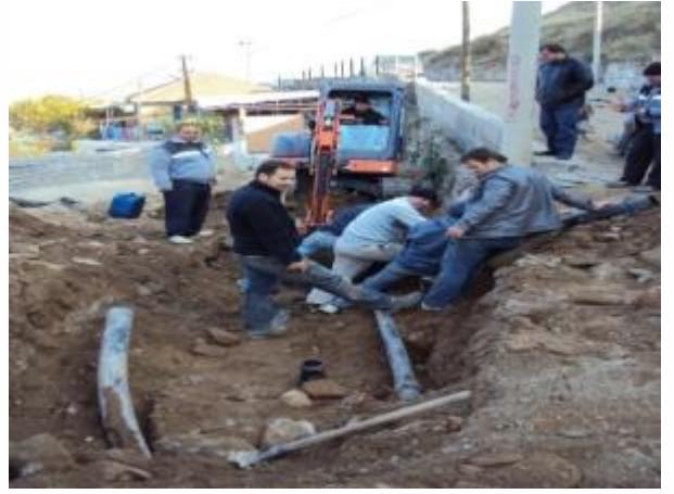
Beşeylül Mahallesi Sümer Oral Caddesi içme suyu şebekesi ana boru ve abone bağlantıları yenileme çalışmalarından görünüm
