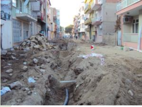
Baklacı Köyü Askeriye içme suyu şebekesi ana boru bağlantıları yenileme çalışmalarından görünüm
