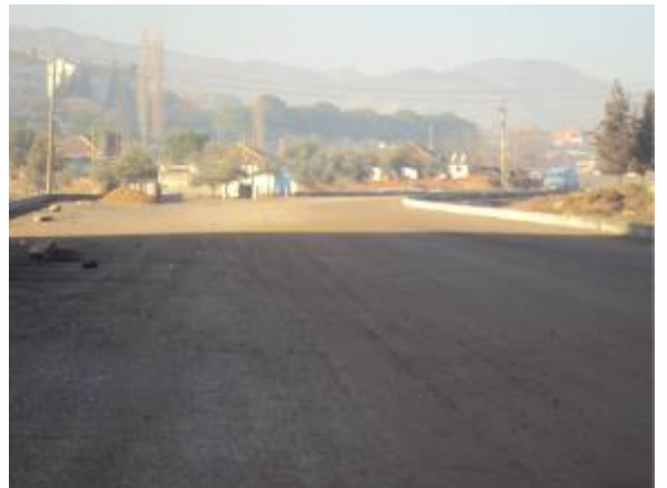
YENİ HASTAHANE YOL ÇALIŞMASI Yol Uzunluğu : 890 Metre Yolun Eni : 20 Metre Bordür Yapımı : 1780 Metre
