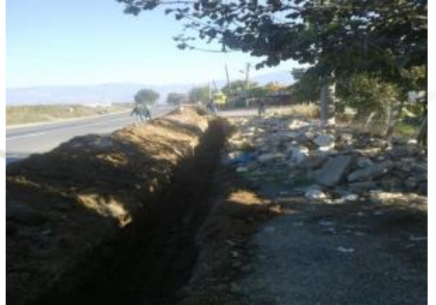
İlçemiz Çataltepe yolu orta refüj yağmur suyu drenaj hattı döşemesi çalışmalarından görünüm
