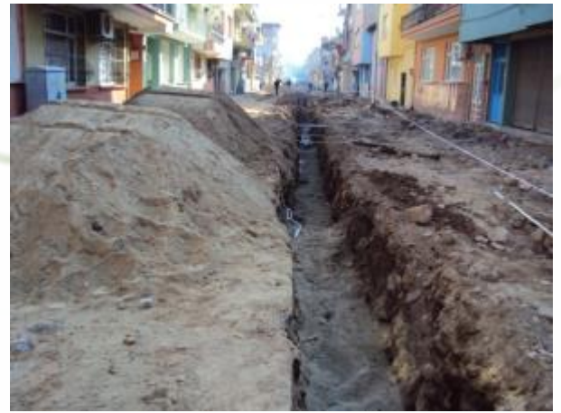
Beşeylül Mahallesi Sümer Oral Caddesi içme suyu şebekesi ana boru ve abone bağlantıları yenileme çalışmalarından görünüm
