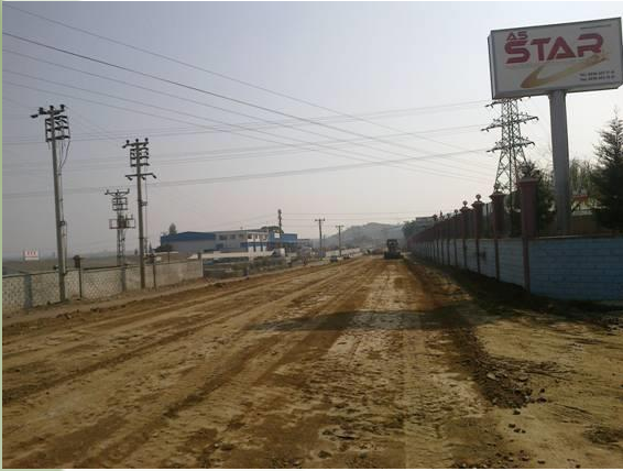
ÇATALTEPE YOL ÇALIŞMASI Yol Uzunluğu : 1800 Metre Yolun Eni : 20 Metre 2.000 Kamyon Dolgu Malzemesi Kullanılmıştır
