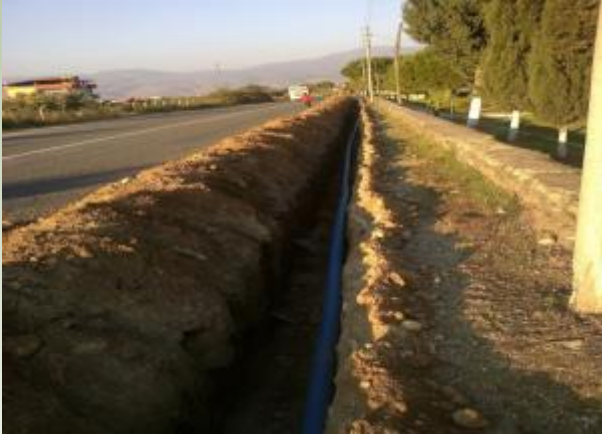
İlçemiz Çataltepe yolu orta refüj yağmur suyu drenaj hattı döşemesi çalışmalarından görünüm
