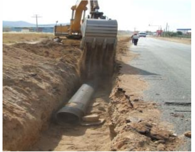
İlçemiz Yenice Mahallesi Beş eylül Caddesi içme suyu şebekesi ana boru ve abone bağlantıları yenileme çalışmalarından görünüm.
