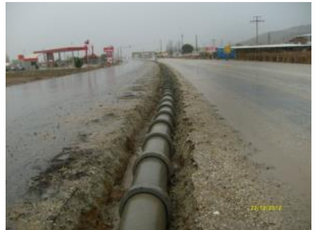
İlçemiz Çataltepe yolu orta refüj yağmur suyu drenaj hattı döşemesi çalışmalarından görünüm
