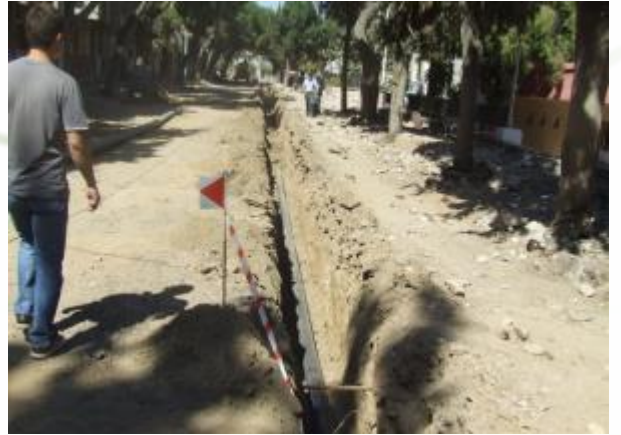
İlçemiz Yenice Mahallesi Beş eylül Caddesi içme suyu şebekesi ana boru ve abone bağlantıları yenileme çalışmalarından görünüm.
