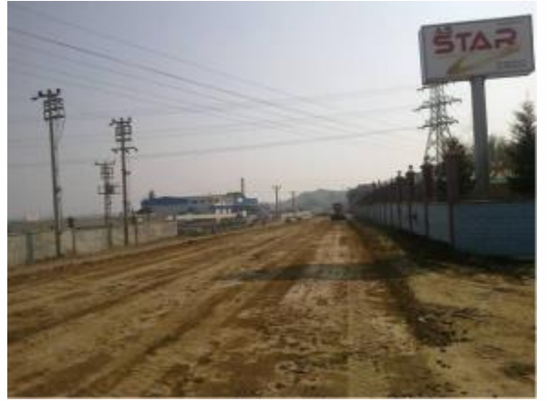
ÇATALTEPE YOL ÇALIŞMASI Yol Uzunluğu : 1800 Metre Yolun Eni : 20 Metre 2.000 Kamyon Dolgu Malzemesi Kullanılmıştır
