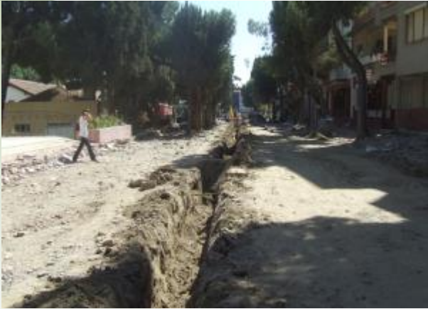
İlçemiz Yenice Mahallesi Beş eylül Caddesi içme suyu şebekesi ana boru ve abone bağlantıları yenileme çalışmalarından görünüm.
