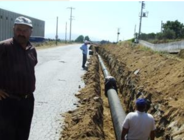
İlçemiz Çataltepe yolu orta refüj yağmur suyu drenaj hattı döşemesi çalışmalarından görünüm
