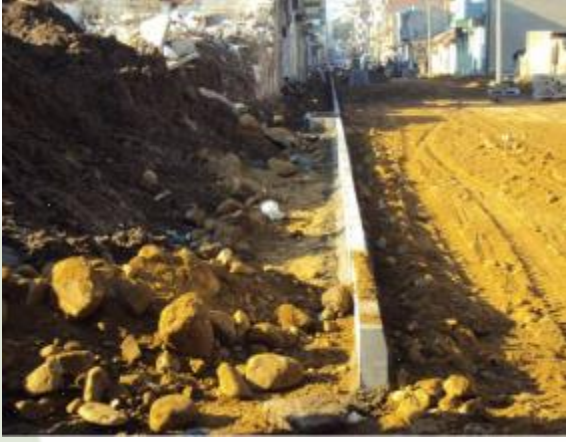
ÇATALTEPE YOL ÇALIŞMASI Yol Uzunluğu : 1800 Metre Yolun Eni : 20 Metre 2.000 Kamyon Dolgu Malzemesi Kullanılmıştır
