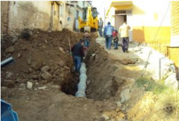
Esentepe Mahallesi Doğuran Sokak, Çamlıbel Caddesi ve Söğüt Çeşme Sokakları içme suyu şebekesi, abone bağlantıları ve kanalizasyon hattı yenileme çalışmalarından görünüm
