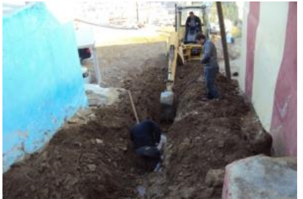
Esentepe Mahallesi Doğuran Sokak, Çamlıbel Caddesi ve Söğüt Çeşme Sokakları içme suyu şebekesi, abone bağlantıları ve kanalizasyon hattı yenileme çalışmalarından görünüm
