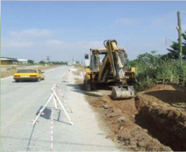
İlçemiz Yenice Mahallesi Beş eylül Caddesi içme suyu şebekesi ana boru ve abone bağlantıları yenileme çalışmalarından görünüm.
