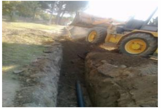
Baklacı Köyü Askeriye içme suyu şebekesi ana boru bağlantıları yenileme çalışmalarından görünüm
