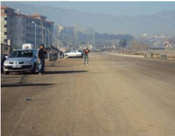
YENİ HASTAHANE YOL ÇALIŞMASI Yol Uzunluğu : 890 Metre Yolun Eni : 20 Metre Bordür Yapımı : 1780 Metre
