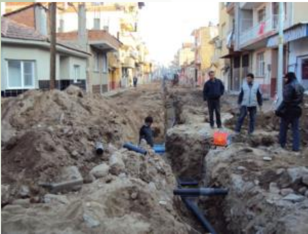
Beşeylül Mahallesi Sümer Oral Caddesi içme suyu şebekesi ana boru ve abone bağlantıları yenileme çalışmalarından görünüm
