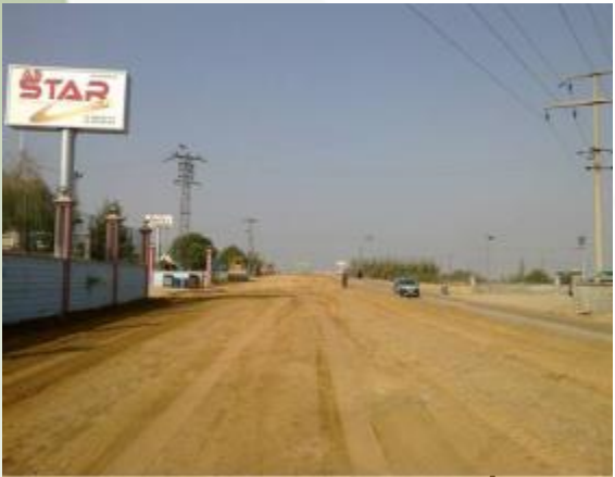
YENİ HASTAHANE YOL ÇALIŞMASI Yol Uzunluğu : 890 Metre Yolun Eni : 20 Metre Bordür Yapımı : 1780 Metre
