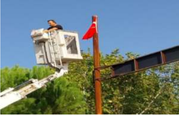
Erenköy bayrak montajı yapıldı.
