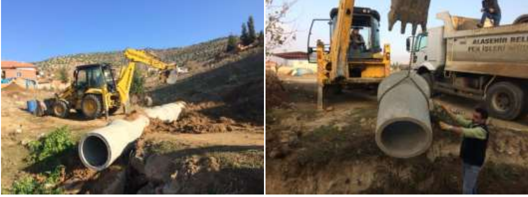
Caberburhan Mahallesi Büz Döşeme
