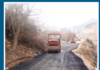
ŞAHYAR: Köy içerisindeki yolların, iyileştirme ve asfaltlama çalışmaları sürüyor. Köyümüze ayrıca kilit parke yardımında da bulunuldu.
