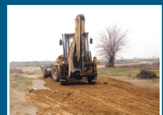
SUBAŞI: Yolların iyileştirme, dolgu ve sıkıştırma çalışmaları tamamlanmış, kaldırım ve tritular çalışmaları içinde bordür desteği yapıldı.
