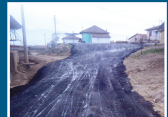
TÜRKMENKÖY (ALCI): Köy içerisindeki yolların, iyileştirme ve asfaltlama çalışmaları tamamlandı.
