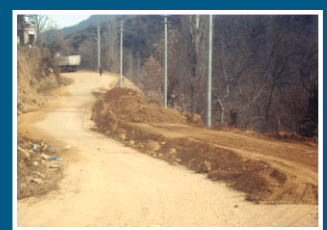
SARIPINAR: Köy içi yolları ve köyü Nazilli'ye bağlayan yolda dolgu, sıkıştırma ve iyileştirme çalışmaları bitirilmiş, imge suyu ilave hattı döşemesi de tamamlanmıştır.
